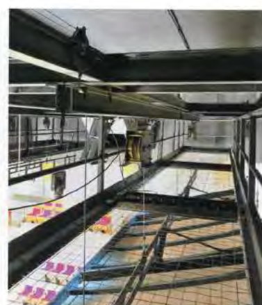
Faux gril de sollicitation ; passerelle filet métallique ; en transparence, une ferme américaine et son réflecteur mobile
