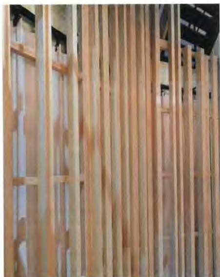
Détail du claustra en fond de salle ; rideau acoustique blanc sur sa patience
