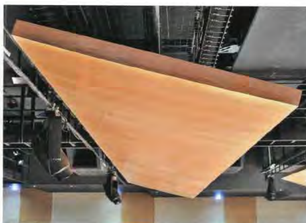
Accès aux équipes électriques, ici appuyées en position focus lumière (accès difficile voir impossible à partir des passerelles)
