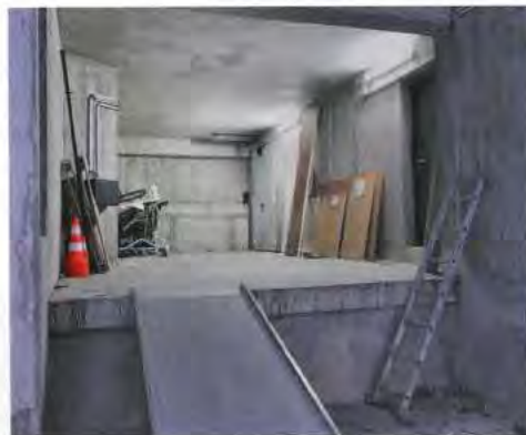
Monte-piano débouchant sur le quai de déchargement au niveau rez-de-chaussée
