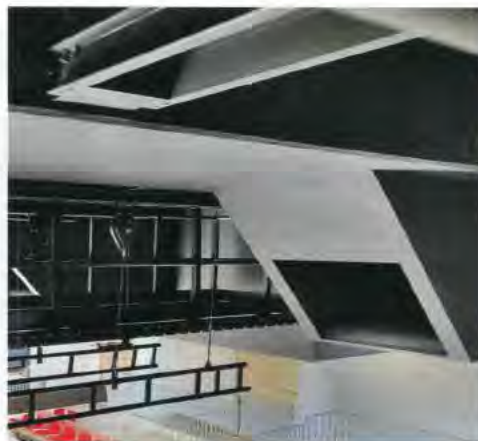
Bouches silencieuses d'extraction ventilation sans grille, sans diffuseur
