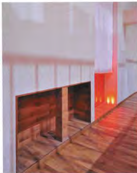
Caisson de soufflage ventilation bois en 1 er plan ; rideau déployé sur un grand miroir de salle en 2 e plan
