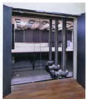
Local "passe-piano" (axe de circulation petite salle vers fosse)
